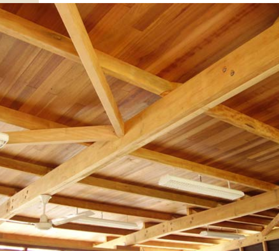
Charpente en Mandioqueira et voligeage en Basralocus, Lycée Gontran Damas, Cayenne (Guyane française).
