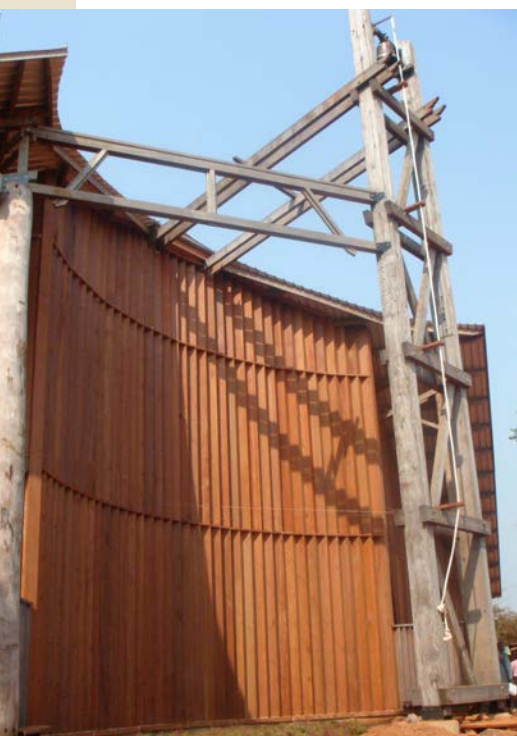
Beffroi et bardage à redents en Mukulungu et poteaux en Tali – Réalisation J.Y. Riaux, Mindourou (Cameroun).
