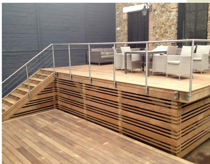
Terrasse surélevée – Création Terrasse Nature, Antony (France).
