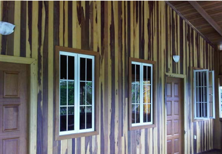
Bardage en Wamara dans une maison d'habitation – Entreprise Durable Wood Products, Georgetown (Guyana).
