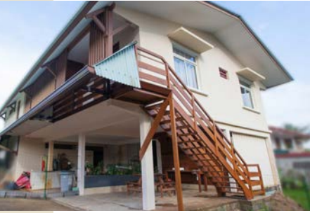
Escalier extérieur en Gaïac de Cayenne, Rémire-Montjoly (Guyane française).
