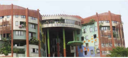
Façade du ministère des Eaux et Forêts, Libreville (Gabon).
