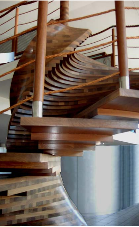
Escalier intérieur en lamellé-collé – Réalisation Les Bois du Pacifique, Nouméa (Nouvelle-Calédonie).
