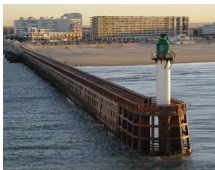
Tillac de la jetée de Calais – Réalisation Bois et Loisirs (France).
