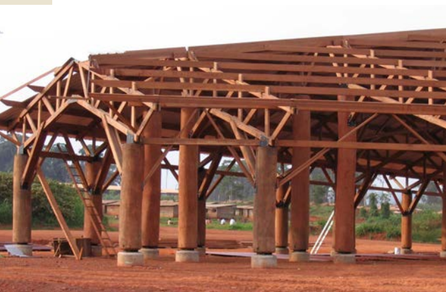
Structure triangulée en Kosipo et poteaux en Tali – Réalisation J.-Y. Riaux Mindourou (Cameroun).
