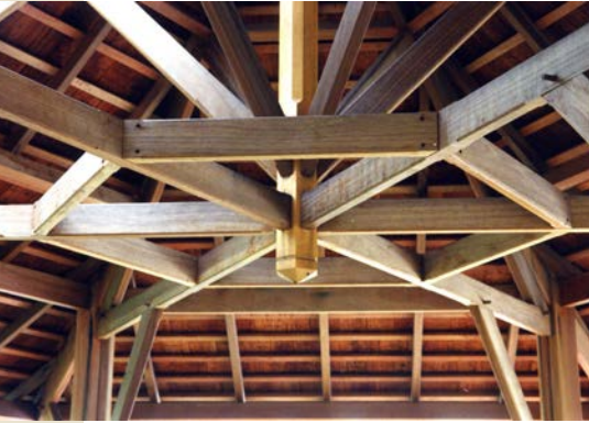
Charpente traditionnelle en Basralocus et bardeaux en Wallaba, Kourou (Guyane française).
