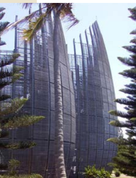
Ossatures lamellées-collées du centre culturel Jean-Marie Tjibaou, Nouméa (Nouvelle-Calédonie).
