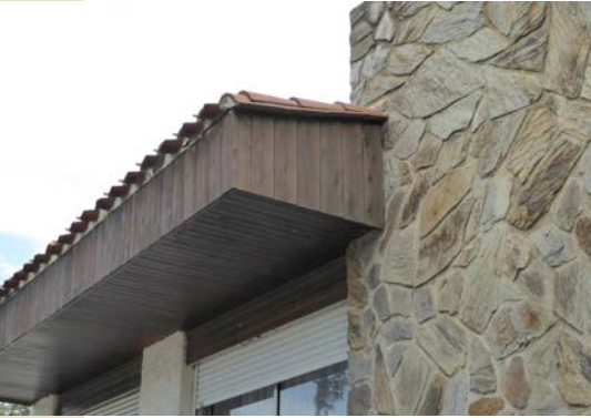
Bardage sur avancée de toit jouxtant un mur de façade revêtu de lloses, Argelès-sur-Mer (France).
