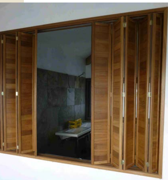
Volet pliant en milieu extérieur abrité – Fournitures, Fibres Industries Bois, La Réunion (France).
