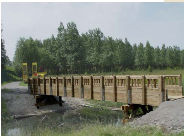
Passerelle en Pin sylvestre traité classe 4 – Réalisation Bois et Loisirs, Loon-Plage (France).
