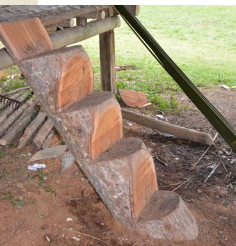
Escalier en Carapa réalisé pour le carbet de Yawapa - Créateur Laurent Pilaoukou (Guyane française).
