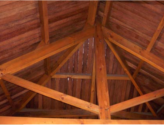
Voligeage en Cocotier sur charpente en Pinus caribaea (Nouvelle-Calédonie).
