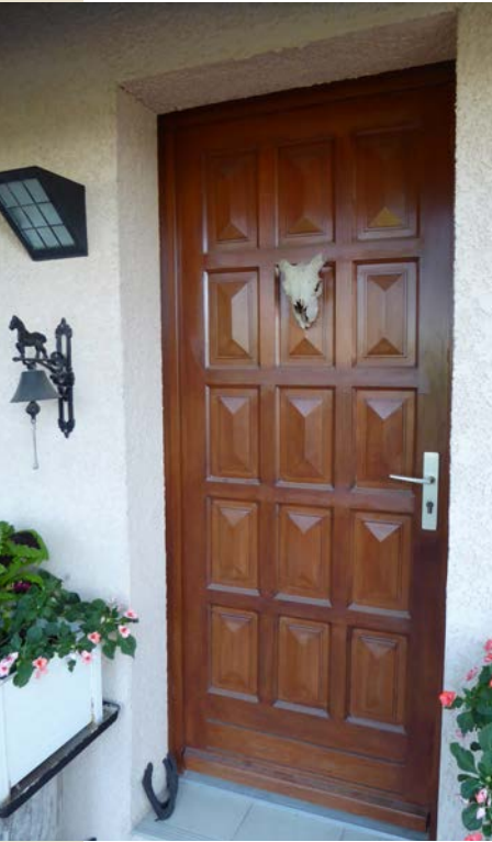
Porte d'entrée à pointes de diamant, sous abri - Teyran (France).
