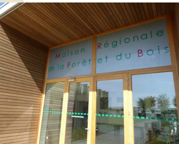
Revêtement extérieur sous abri en Peuplier thermo-traité, maison régionale de la Forêt et du Bois, Châlons-en-Champagne (France).
