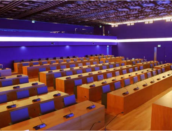
Placage des pupitres et revêtement de sol en Garapa, salle du conseil de l'Hôtel de ville, Montpellier (France).
