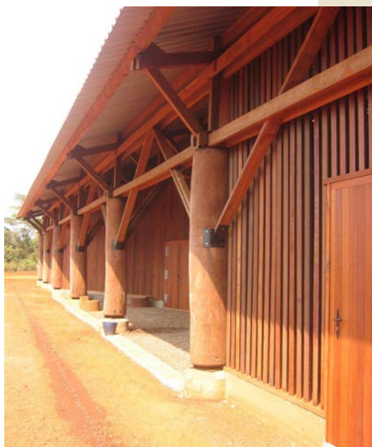
Porte en Moabi, poteaux en Tali, charpente en Kosipo, bardage à claire-voie en Mukulungu – Réalisation J.Y. Riaux, Mindourou (Cameroun).
