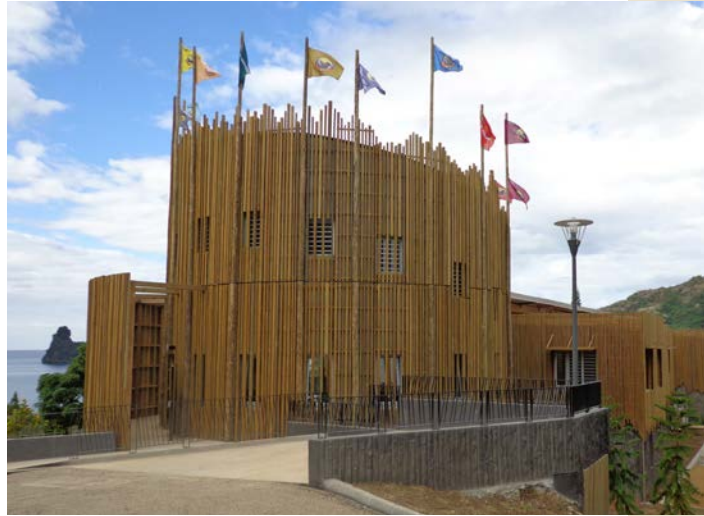
Bardage résille de la mairie de Hienghène – Réalisation : Les Charpentiers du Nord (Nouvelle-Calédonie).
