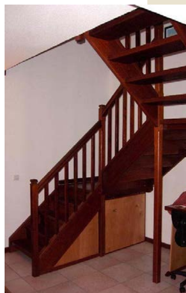
Escalier demi-tournant en Kohu, Nouméa (Nouvelle-Calédonie).
