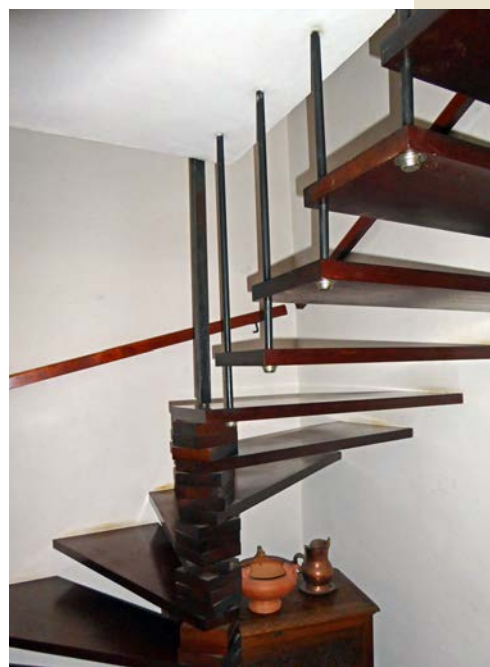
Escalier suspendu demi-tournant, Argelès-sur-Mer (France).
