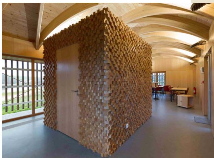
Lamellé-collé et aménagement intérieur mixtes Hêtre et Épicéa – Les Woodies, des gîtes à vivre et une vitrine technologique pour la construction en Hêtre, Terres de Hêtre® ; communauté de communes de la Vôge Vers les Rives de la Moselle, Xertigny (France).
