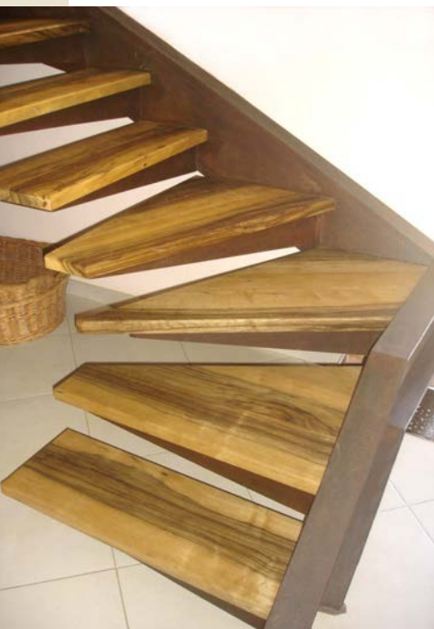
Escalier suspendu demi-tournant (Fraké bariolé), Saint-Gély-du-Fesc (France).
