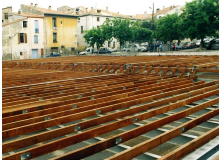
Lambourrage sous le platelage de la place du Forum Saint-Martin, Perpignan (France).
