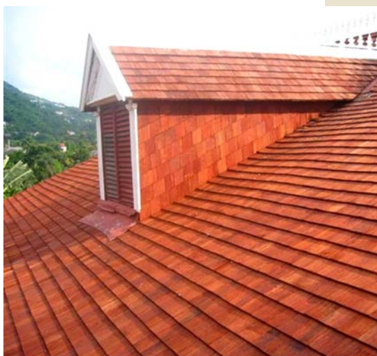
Couverture en bardeaux – Réalisation Woods Direct International, LLC (Jamaïque).
