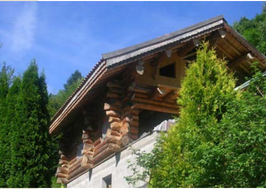
Construction de type « fuste », Plainfaing (France).
