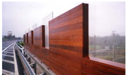
Écran de protection phonique, autoroute A10, Châtelleraut (France).
